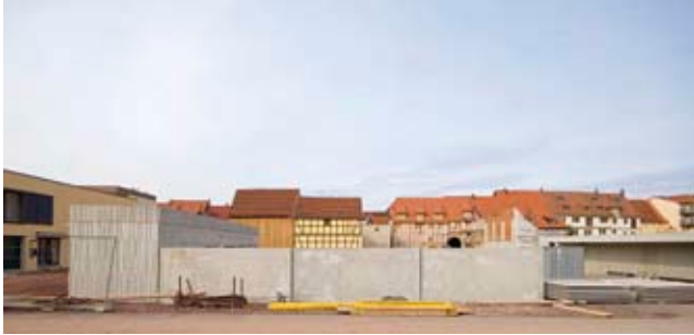
Neue Gartenmauern im historischen Blockrand
