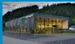
Betriebsgebäude mit Produktionshalle und Büros in Probstzella Foto: Michael Christian Peters
